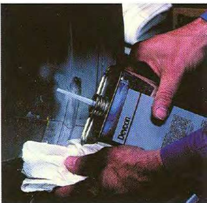
Si la superficie está aceitosa o grasosa, desengrasarla con Devcon Cleaner Blend 300.
