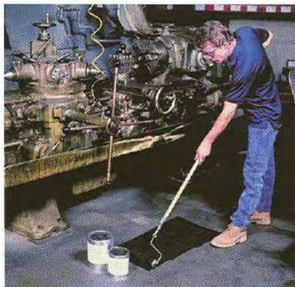
Con granulos de carburo de silicio, Floor Grip™ produce un excepcional acabado antideslizante en pasillos, rampas, muelles de carga y áreas resbaladizas cerca de las máquinas.
