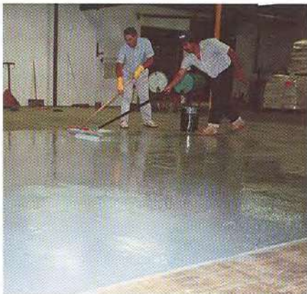
Epoxy Coat™ 6500 Non VOC es un revestimiento autonivelable diseñado para grandes aplicaciones de escala industrial. Se seca hasta dejar un acabado extremadamente durable, resistente a los productos químicos.
