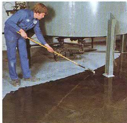
Concrete Primer 1000 es un revestimiento 100% sólidos que penetra y sella las superficies de concreto y mejora la adhesión de los revestimientos Floor Savers.
