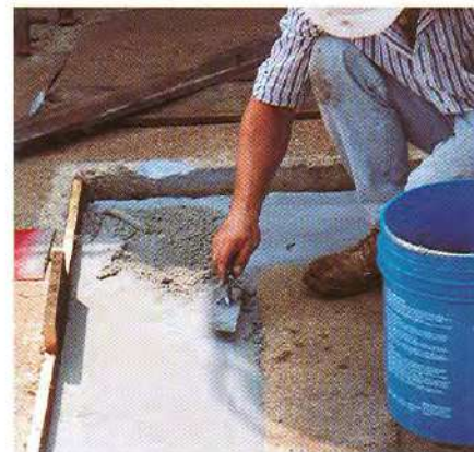
Floor Patch™ es un compuesto multipropósito para remendar pisos con una resistencia tres veces mayor que la del concreto. Fragua rápidamente y tiene una excelente resistencia química.
