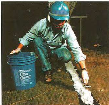
Ultra Quartz™ es un compuesto de remiendos para pisos para tránsito pesado con excelente resistencia a la compresión y a los productos químicos, ácidos, álcalis, solventes, e hidrocarburos.
